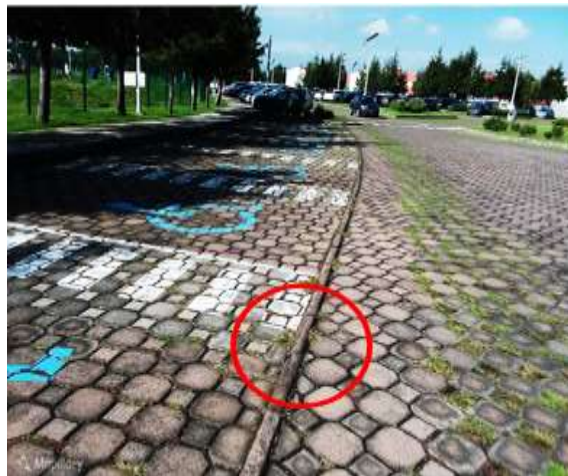
Imagen 31 Cajones de estacionamiento
