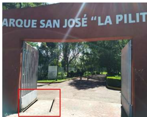
Imagen 34 Rampa de acceso al parque
