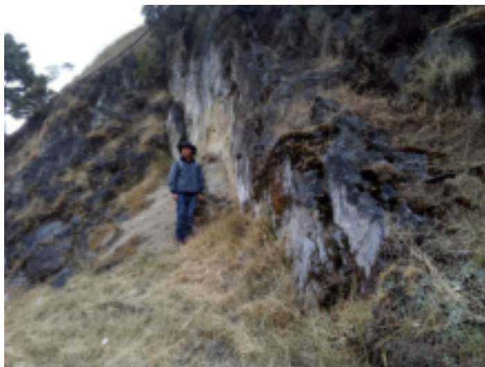
Figura. 4.27 Falla que presenta alteración hidrotermal con azufre nativo. (Altura de la persona 1.75m)
