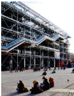
Imagen 1. Beubourg o Centre Georges Pompidou de Renzo Piano y Richard Roger en París, (Tomado de https://es.wikipedia.org/wiki/Edificio_Lloyd%27s#/media/Archivo:Lloyds_building_taken_2011.jpg )
