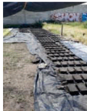
Imagen 7. Adobe autofabricado: Abaratamiento de material y autoconstrucción para abatir costos. Fuente: Moretti, 2021.
