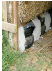
Imagen 6. Reutilización de neumáticos y materiales baratos como la paja. Fuente: Moretti 2021.
