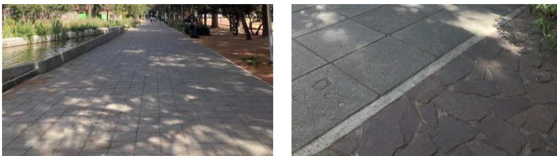
Figura 33. Pavimentos del acceso peatonal. Fuente: Elaboración propia.
