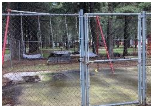
Figura 9. Barda perimetral de la zona de juegos para personas con discapacidad. Fuente: Elaboración propia.
