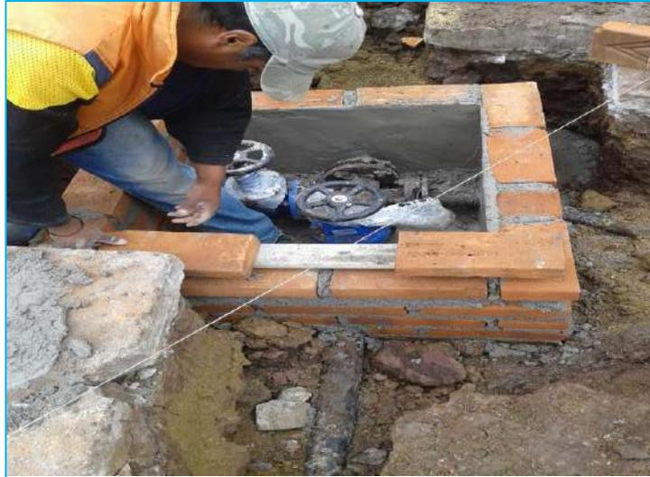
**Figura 3.4.4 Caja de válvulas de crucero 9 de la línea de conducción al tanque la Joya.**
