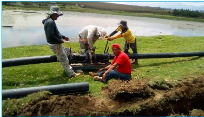
**Figura 3.2.1 Termofusión de la tubería de 6” en “La presita”**
