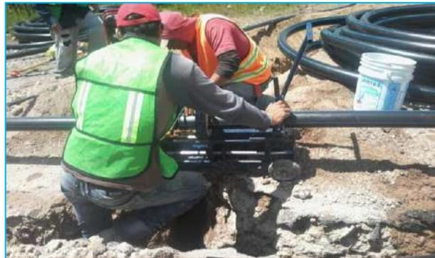
**Figura 3.2.2 Termofusión de la tubería de 3"**
