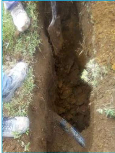
**Figura 3.6.1 Sondeo para encontrar la línea existente**
