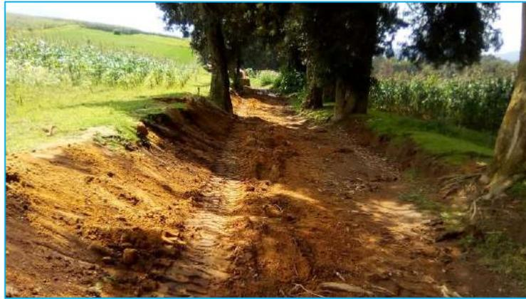
**Figura 3.2.3 Excavación en línea de conducción hacia el tanque Bonxho**
