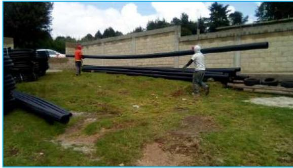
**Figura 3.2 Suministro de la tubería de 75mm y 150mm de diámetro.**
