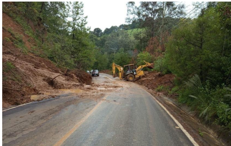
Imagen 5.22. Deslizamiento en carretera San Miguel Tecamatlán-San Simón el Alto 22 de agosto de 2024
