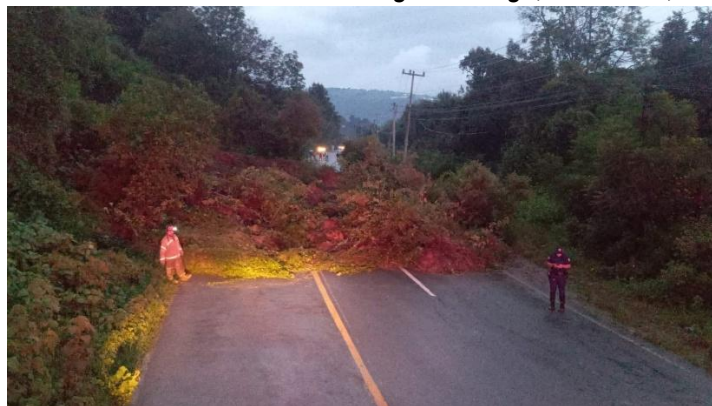
Imagen 5.16. Deslizamiento en carretera Tenancingo-Tenango, La Mesita, 4 de octubre de 2025
