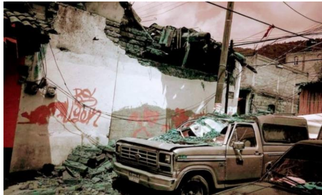
Imagen 5.5. Daños ocasionados por sismo del 19 de septiembre de 2017 en San Miguel Tecamatlán
