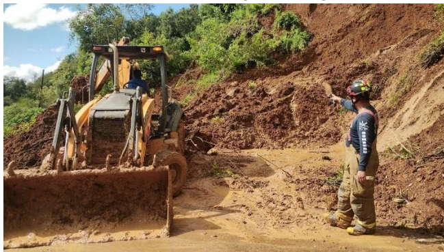
Imagen 5.20. Deslizamiento en carretera Tenancingo-Tenango, La Mesita, 10 de octubre de 2025
