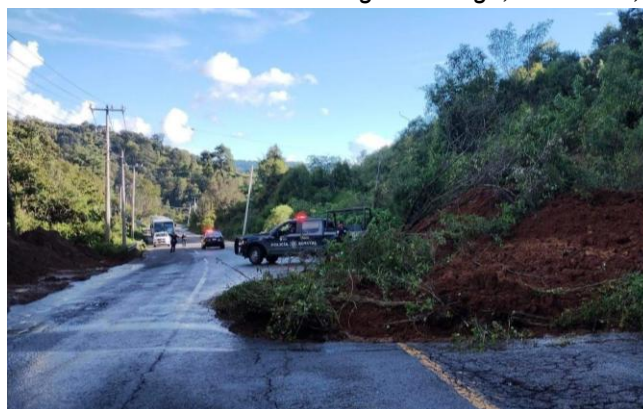
Imagen 5.17. Deslizamiento en carretera Tenancingo-Tenango, La Mesita, 6 de octubre de 2025
