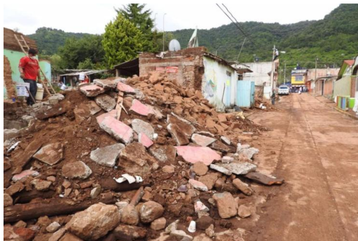
Imagen 5.4. Daños ocasionados por el sismo del 19 de septiembre de 2017 en San Miguel Tecamatlán
