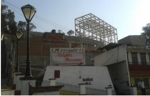
Foto 53. Construcción del Teatro al aire libre sobre el cerro del Calvario
