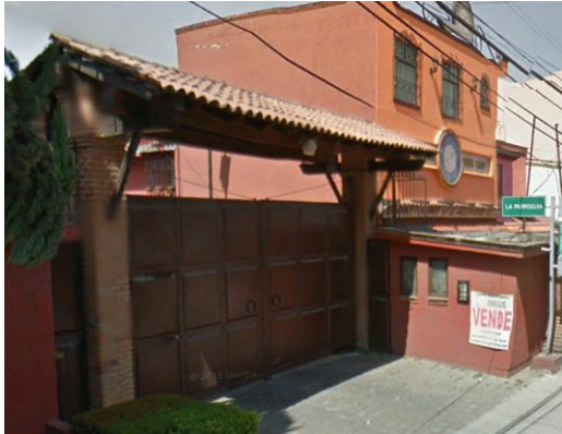
Foto 2. Fraccionamiento, Av. Estado de México
