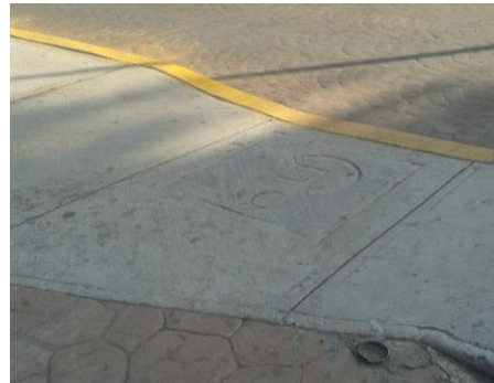
Foto 52. Rampa para Discapacitados. Señalamiento horizontal.
