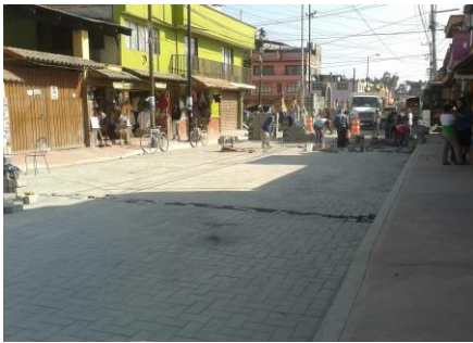
Foto 30. Vialidad en reparación
