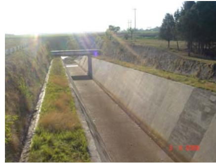
( b ) Obra de excedencias
