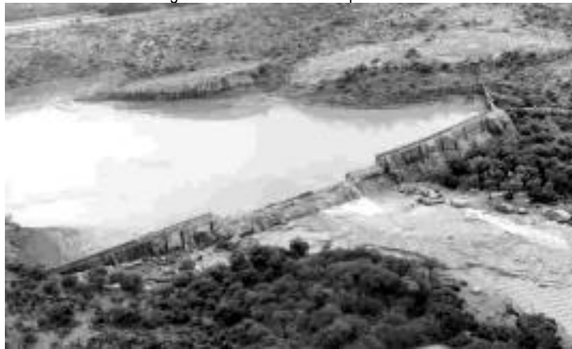
Fotografía 1. Vista aérea de la presa Dolores
