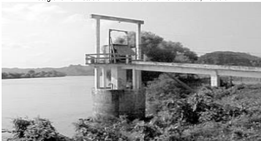
Fotografía 19. Estación hidrométrica en el río Tecolutla, Veracruz
