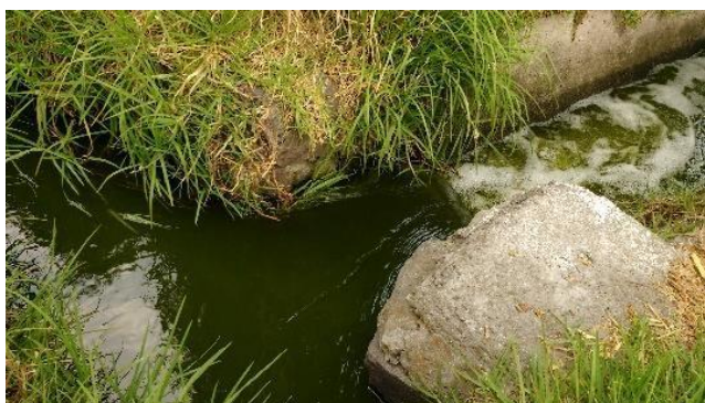
Figura 5.6. Bordo las Maravillas, desviación de agua por canal (Fuente: Obtención en campo)
