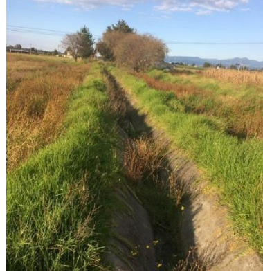
Fotografía 26. Canal de desvío de agua (Fuente: Obtención en campo)
