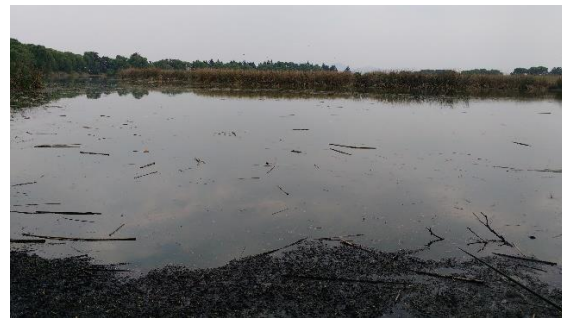
Figura 5.5. Bordo las Maravillas, sedimentación apreciable en temporada de estiaje (Fuente: Obtención en campo).
