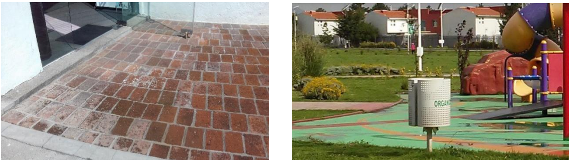
Figura 12. Escalones en el acceso a facilidades.
