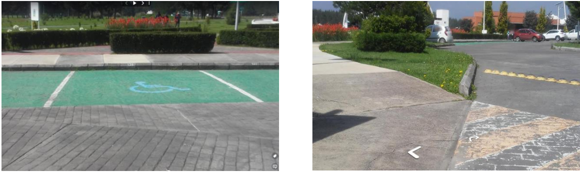
Figura 11. Estacionamiento dedicado (izquierda) sin conexión a rampa de acceso (derecha).
