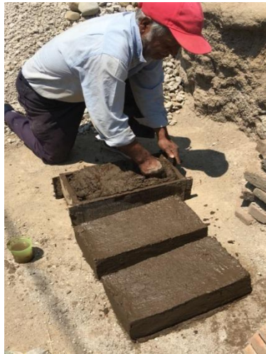
Fotografía 24: Apisonado de adobe en molde
