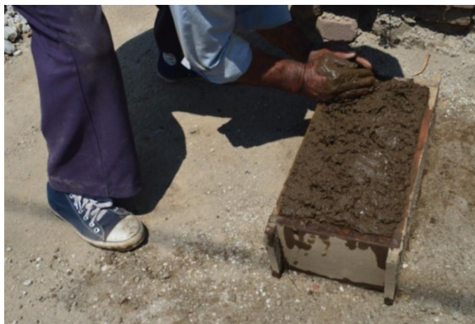
Fotografía 23: Relleno de molde
