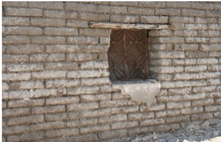
Fotografía 27: Vista lateral de un muro
