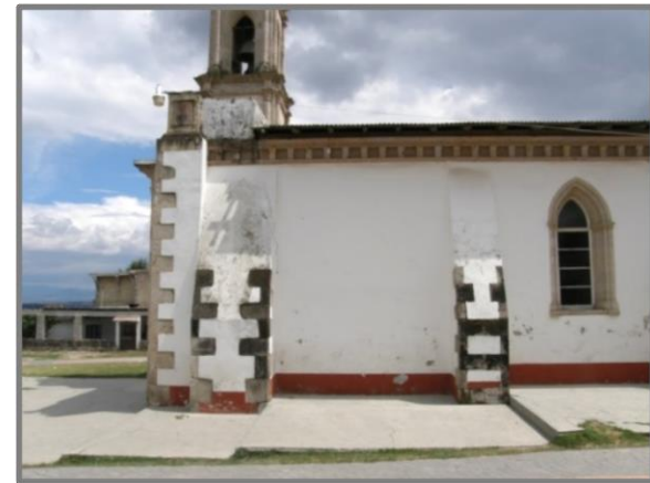
Fotografía 2: Vista lateral de la iglesia se pueden observar los muros de cantera y la cubierta. Fuente: Autor.
