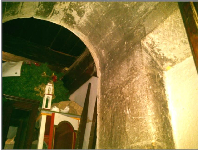
Fotografía 14 Interior de la estructura que alberga la escalera que permite acceder al coro y la torre. Fuente: Autor.
