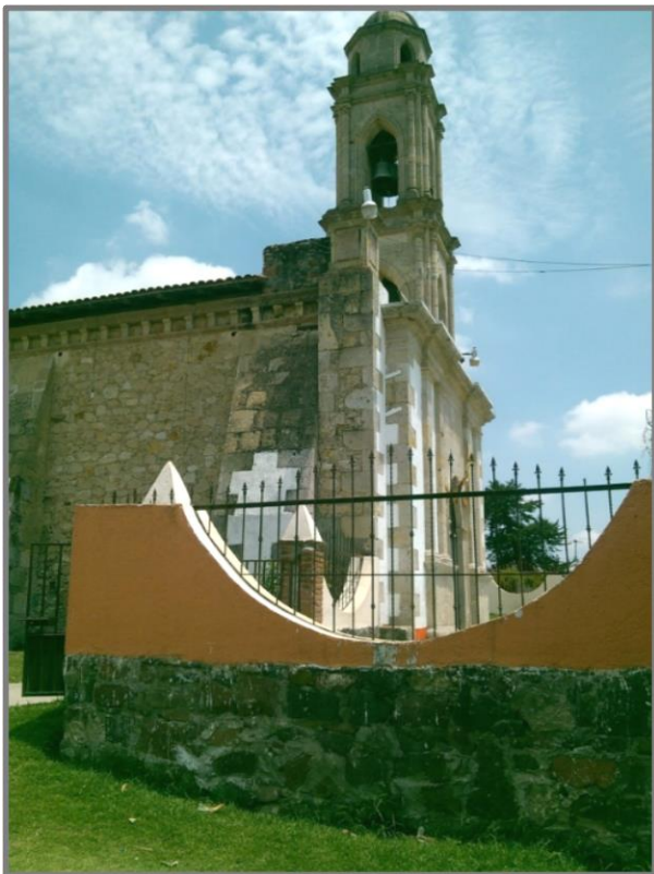
Fotografía 12 Torre de la parroquia de la Providencia vista desde el lado sur del inmueble Fuente: Autor.
