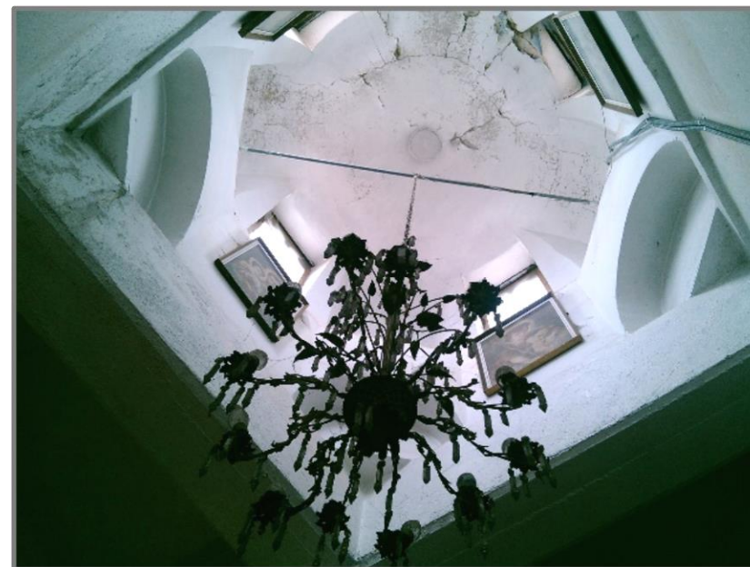
Fotografía 20 Vista del interior de la cúpula. Fuente: Autor.
