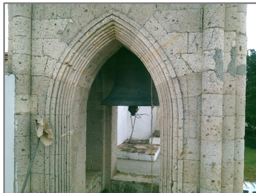
Fotografía 13 arcos ojivales elemento distintivo en la torre. Fuente: Autor.
