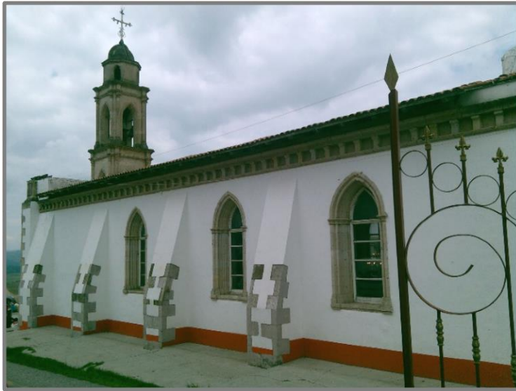
Fotografía 15 Contrafuertes del inmueble vistos desde el lado norte. Fuente: Autor.
