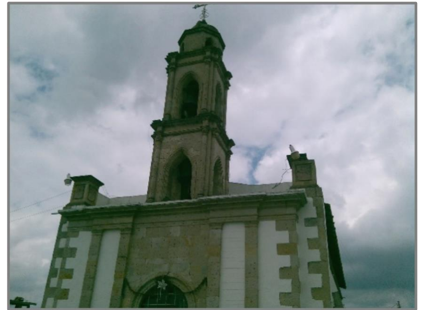
Fotografía 11 Existencia de alumbrado y cableado en malas condiciones. Fuente: Autor
