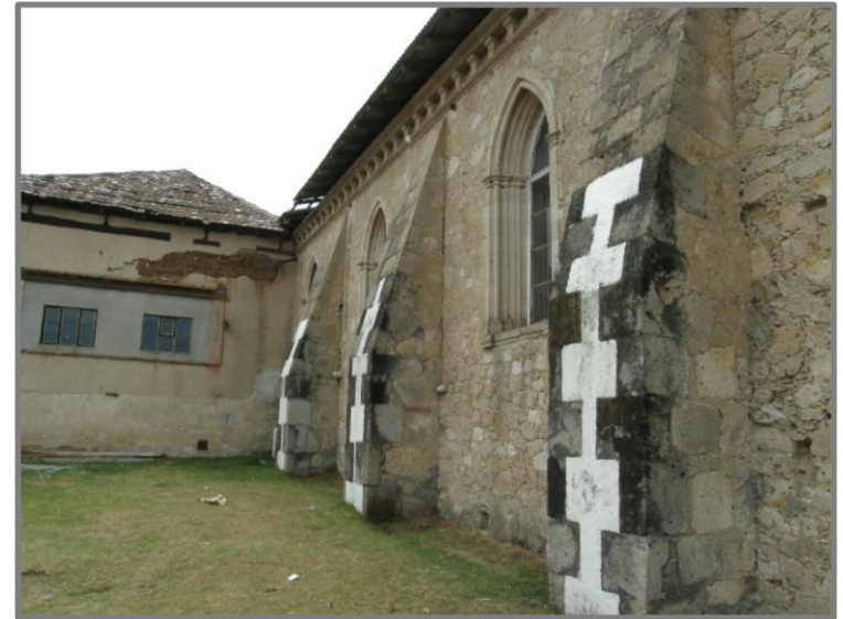
Fotografía 16 Contrafuertes del inmueble vistos desde el lado sur. Fuente: Autor.
