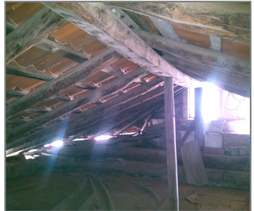
Fotografía 18 Vista interior de la cubierta de teja.
