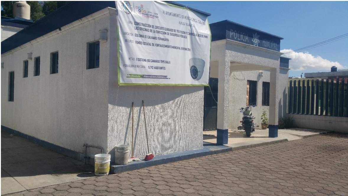
Fuente propia (2018). Entrada al edificio en el que se ubica la Oficialía Mediadora-Conciliadora de Mexicaltzingo.
