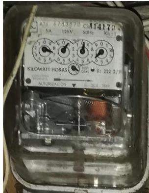
Figura 2.1. Medidor energía eléctrica analógico.
