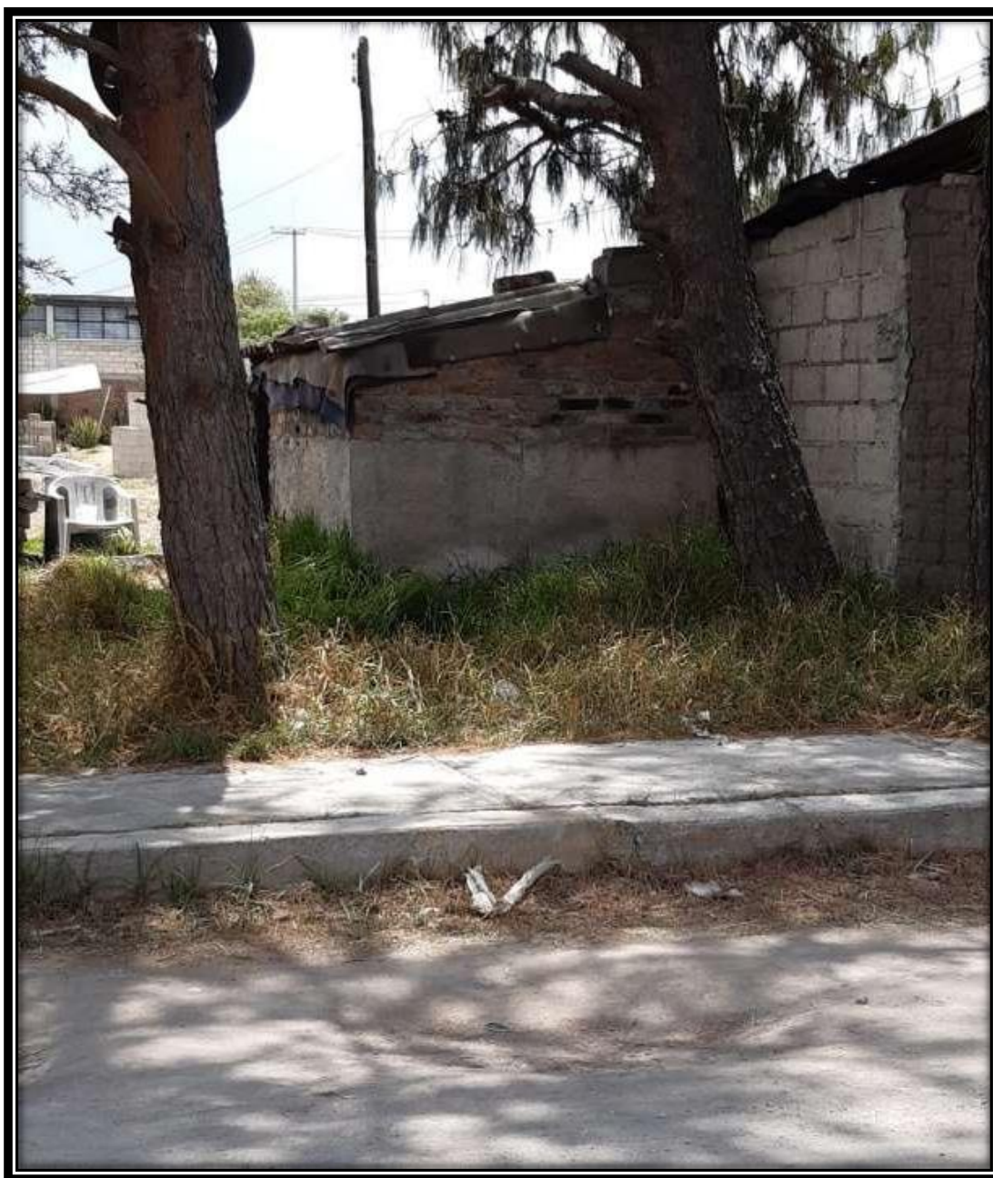
Paredes y techumbre de temazcal contiguo a la casa habitación
