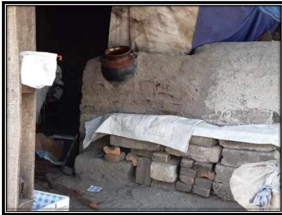
Temazcal tradicional otomí con olla de barro adosada a la parte superior de la hornilla para calentar agua. Su construcción data de más de 25 años.
