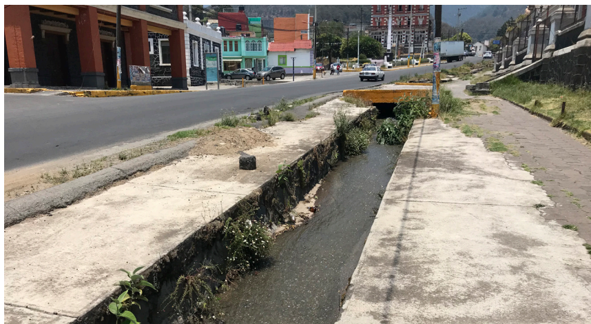
Imagen IV: “Desperdicio de Agua Potable en San Rafael Estado de México, Municipio de Tlalmanalco, Estado de México”
