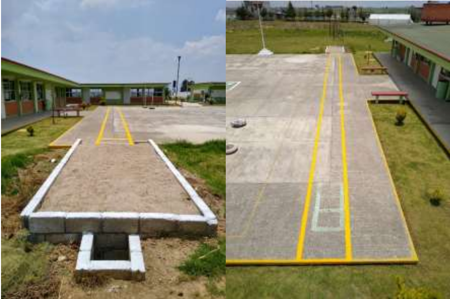
Figura 9 Cajón de arena terminado
