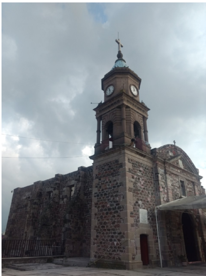
Foto 3. Construcción del siglo XVIII dedicada al arcángel Miguel, 16 de septiembre de 2019. AUTOR: Gerardo González Reyes.
