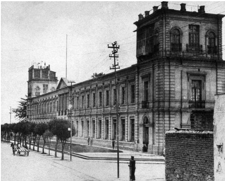
Antes de 1928 la fachada del Instituto Literario de Toluca, tenía este aspecto, no había sido construido el monumento a los maestros.
