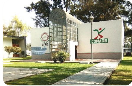
Imagen No. 27 “Instalaciones de la Escuela Nacional de Entrenadores Deportivos ENED”.
