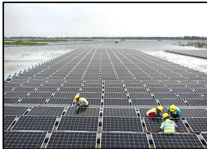
Figura 8. Paneles solares flotantes en un lago creado tras el derrumbe de minas de carbón abandonadas en Liulong, China.
