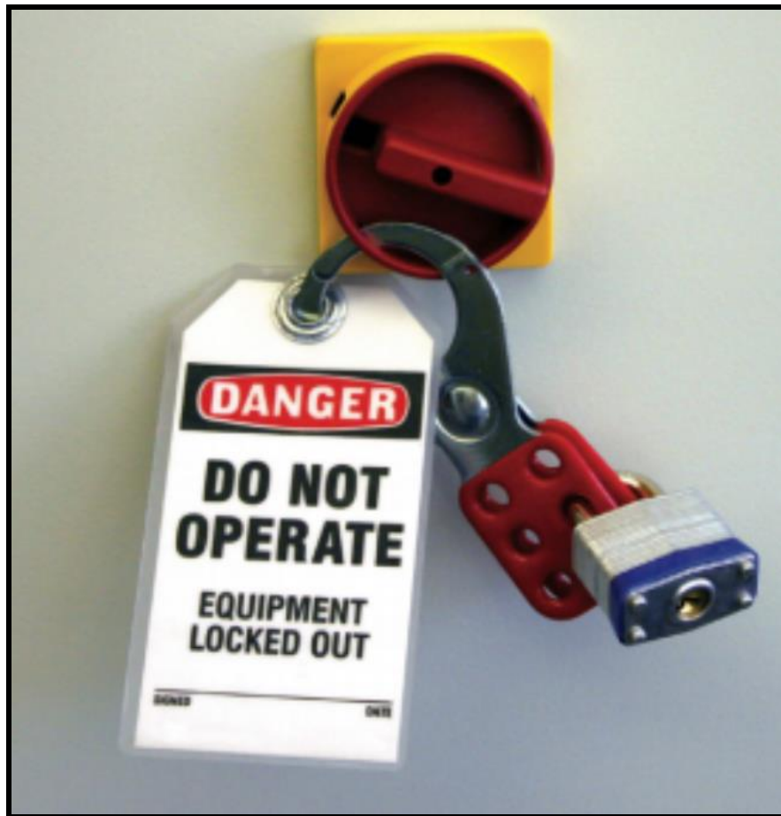
Figura 21. Dispositivo de bloqueo LOTO
