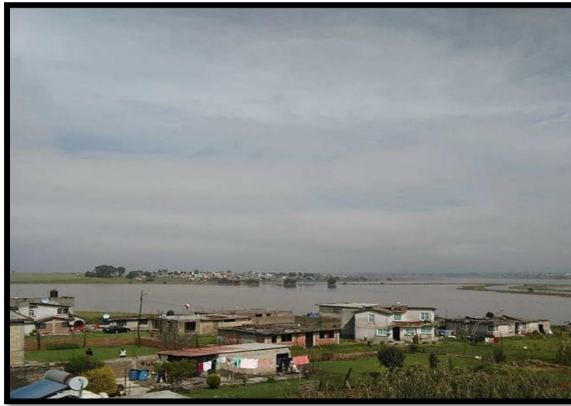
Figura 5. Asentamientos cercanos a la presa
