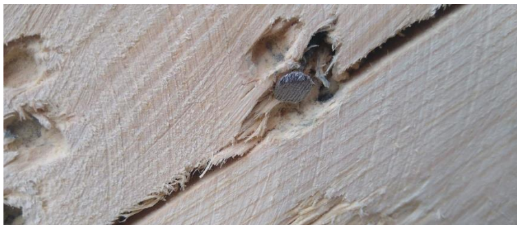
Figura 5.- Clavos salidos (elaboración propia, 2022)
