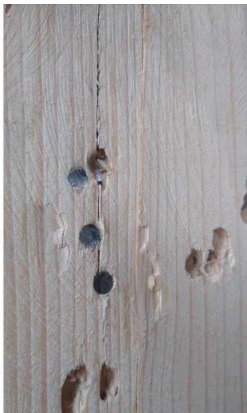
Figura 53. - Defectos de calidad en el clavado de balonas (elaboración propia, 2022).
