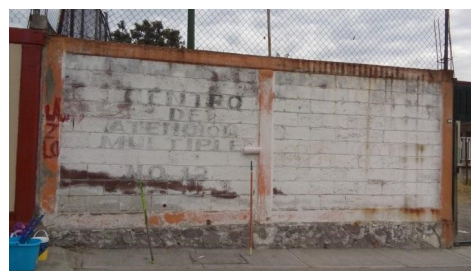
Imagen 1. Registro fotográfico previo al inicio de la intervención plástica
