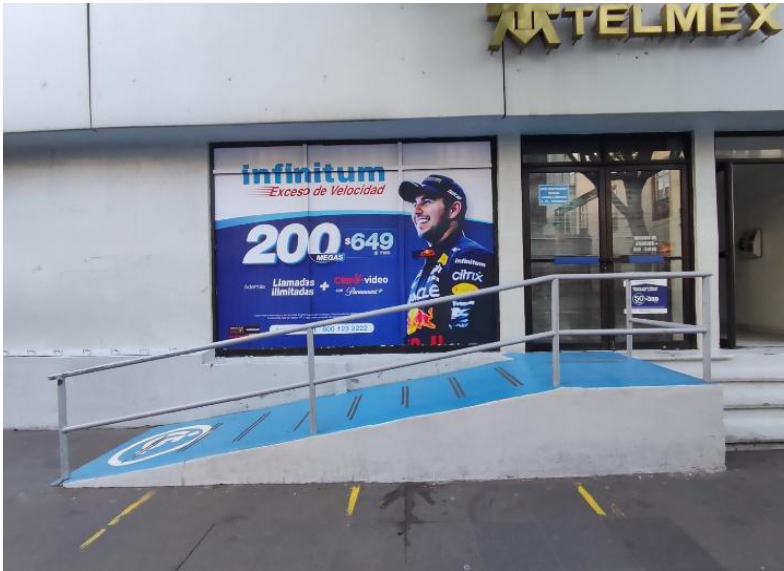
Imagen 4. Rampa para acceso a servicios comerciales
