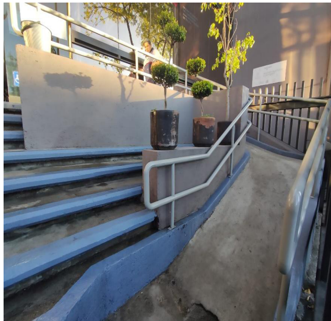
Imagen 1. Rampa de servicio público
