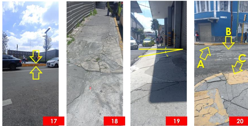
Ilustración 43 - Infraestructura poco amigable a la peatonalización, Fuente: elaboración propia.
