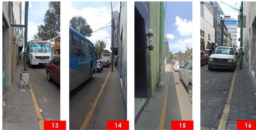
Ilustración 42 - Ancho insuficiente para el paso peatonal, Fuente: elaboración propia.
