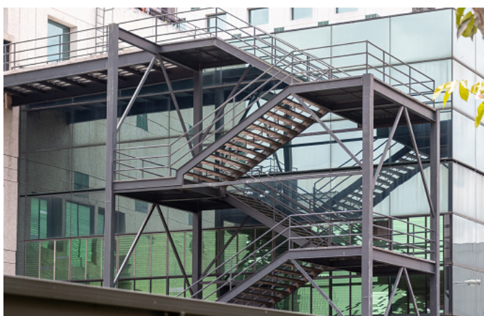
Imagen 1. Escaleras de emergencia, una forma de evacuación excluyente.
