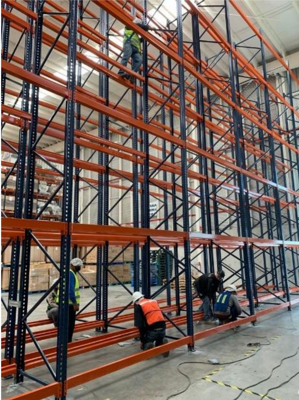
**Figura No. 14** Colocación de vigas de carga en color naranja
