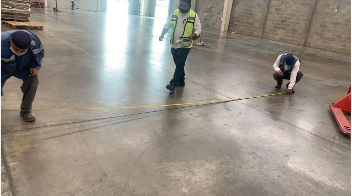
**Figura No. 7** Medición con cinta métrica para calcular el espacio de instalación.
