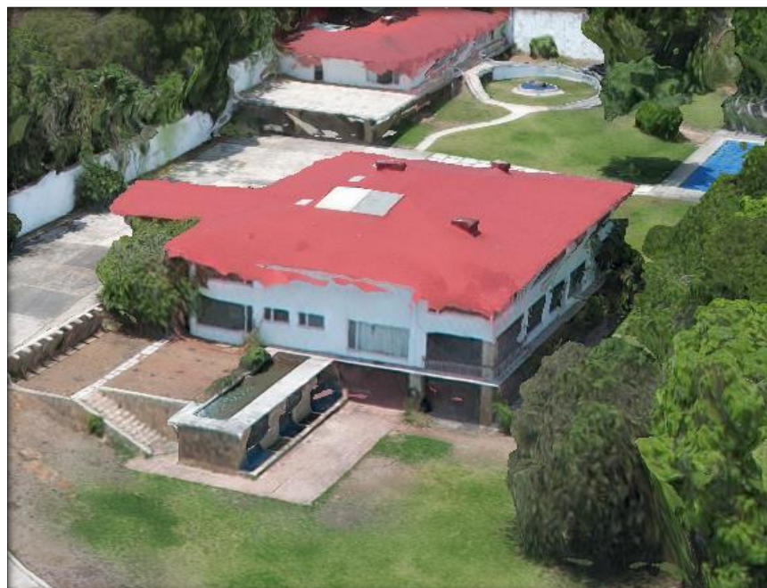
Imagen 7. Construcción vista con modelo 3D.
