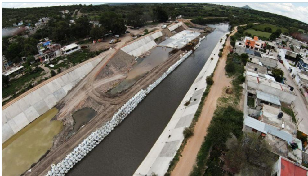
Figura 12. Revestimiento del Río Tula
