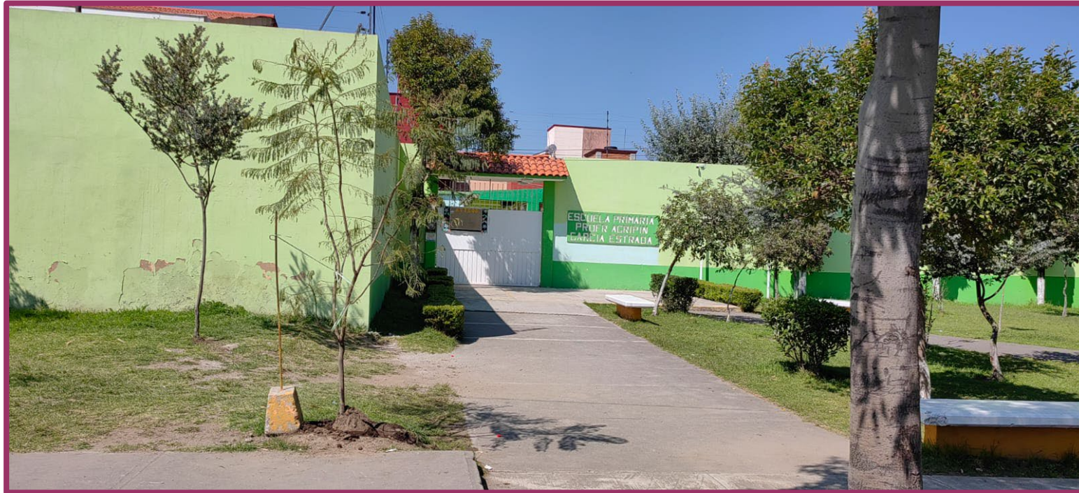
Figura 29. Escuela primaria Agripin García Estrada, al poniente del fracc. Paseos del Valle III. Fuente: foto tomada el 20 de octubre de 2024.
