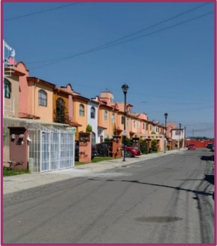
Figura 25. Vista de la calle valle del matlatzinco, en el fracc. Paseos del Valle III. Fuente: foto tomada el 20 de octubre de 2024.
