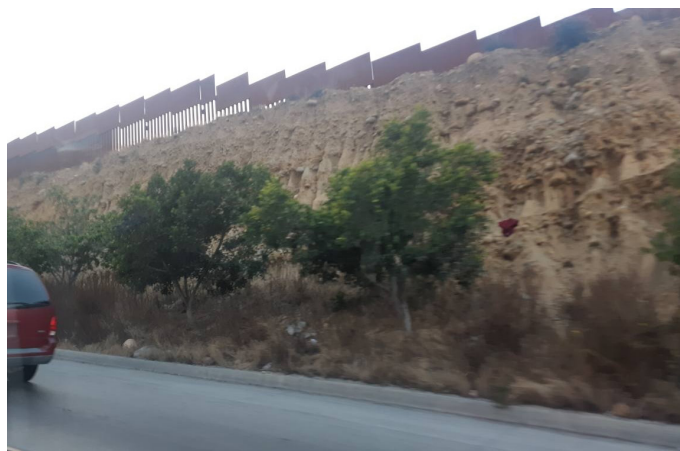
Figura 4. Una vista al muro desde la carretera
