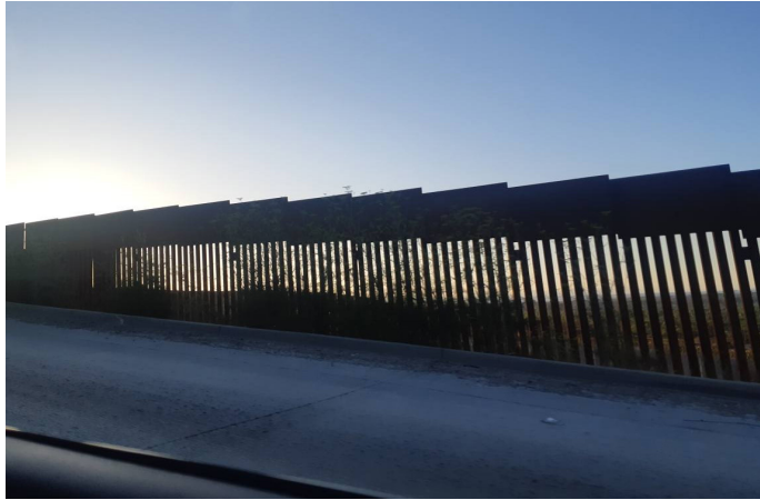
Figura 3. Una vista al muro desde la carretera
