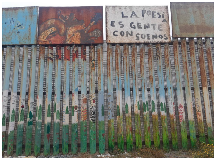
Figura 12. Detalle del muro
