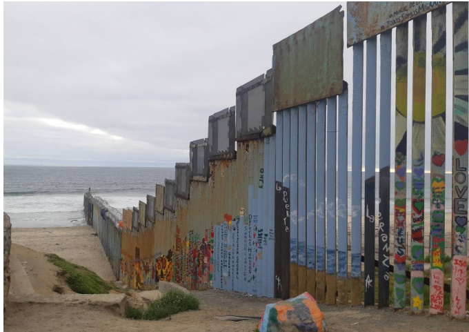
Figura 1. El principio del muro que divide México y Estados Unidos (Tijuana, México)
