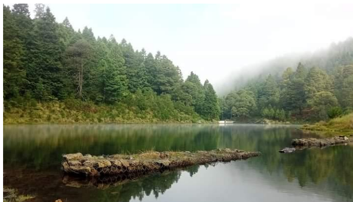
Ilustración 3 Presa "Los Ajolotes", San Mateo Capulhuac, Oztolotepec
