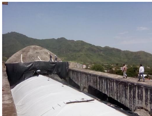
Imagen 12: Cobertura de la Bóveda de cañón del templo del Divino Salvador
