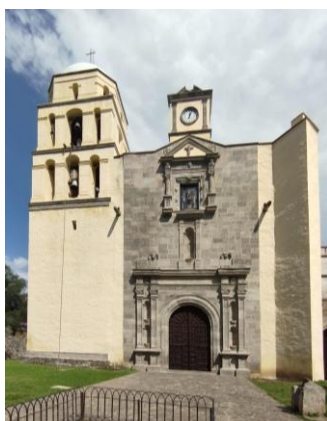
Imagen 5: Fachada actual del templo del Divino Salvador
