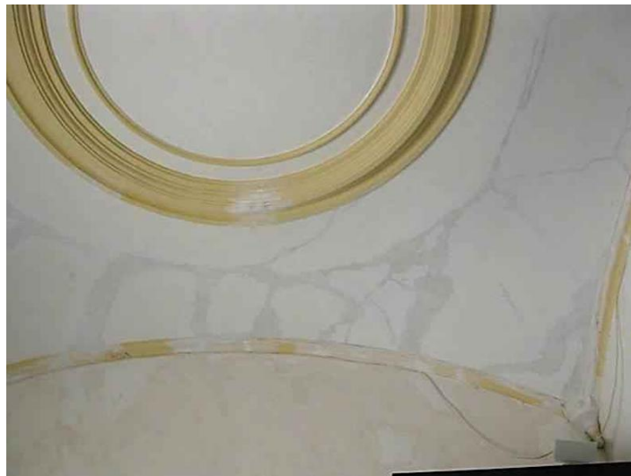
Imagen 68: Reparación de grietas
