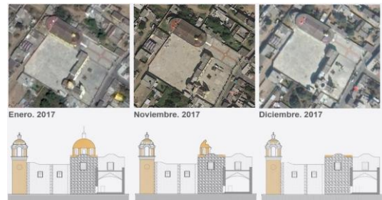
Imagen 48: Comparativa entre el estado del templo antes y después del sismo del 19 de septiembre de 2017
