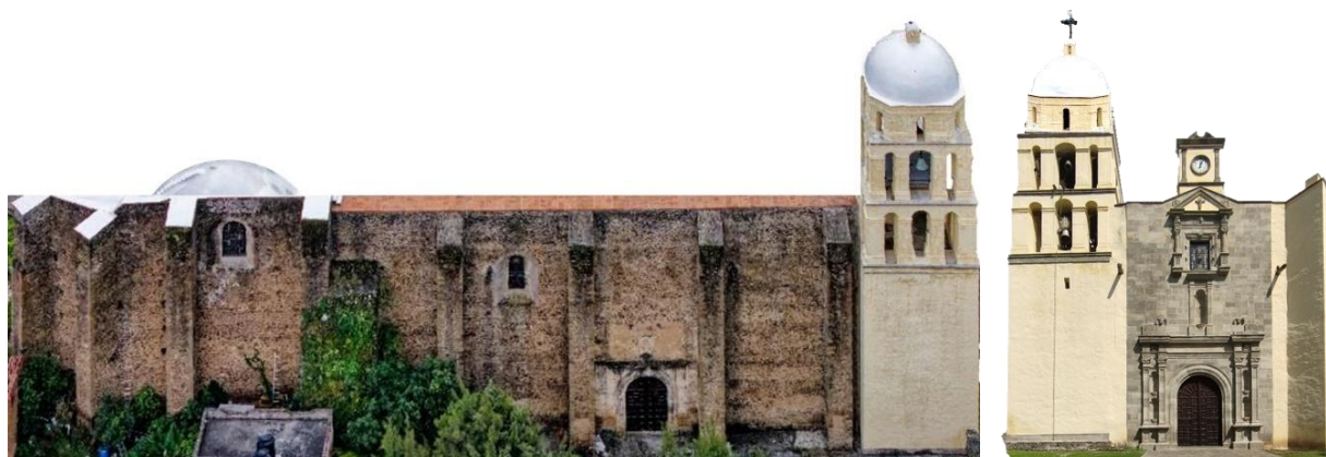
Fachada Norte y Fachada Oeste
