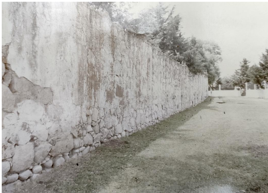
Figura 3. Vista lateral derecha del muro perimetral del casco de Santa Catarina
