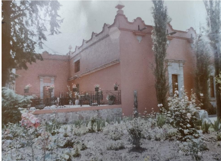
Figura 5. Vista de un lateral de la casa grande de Santa Catarina
