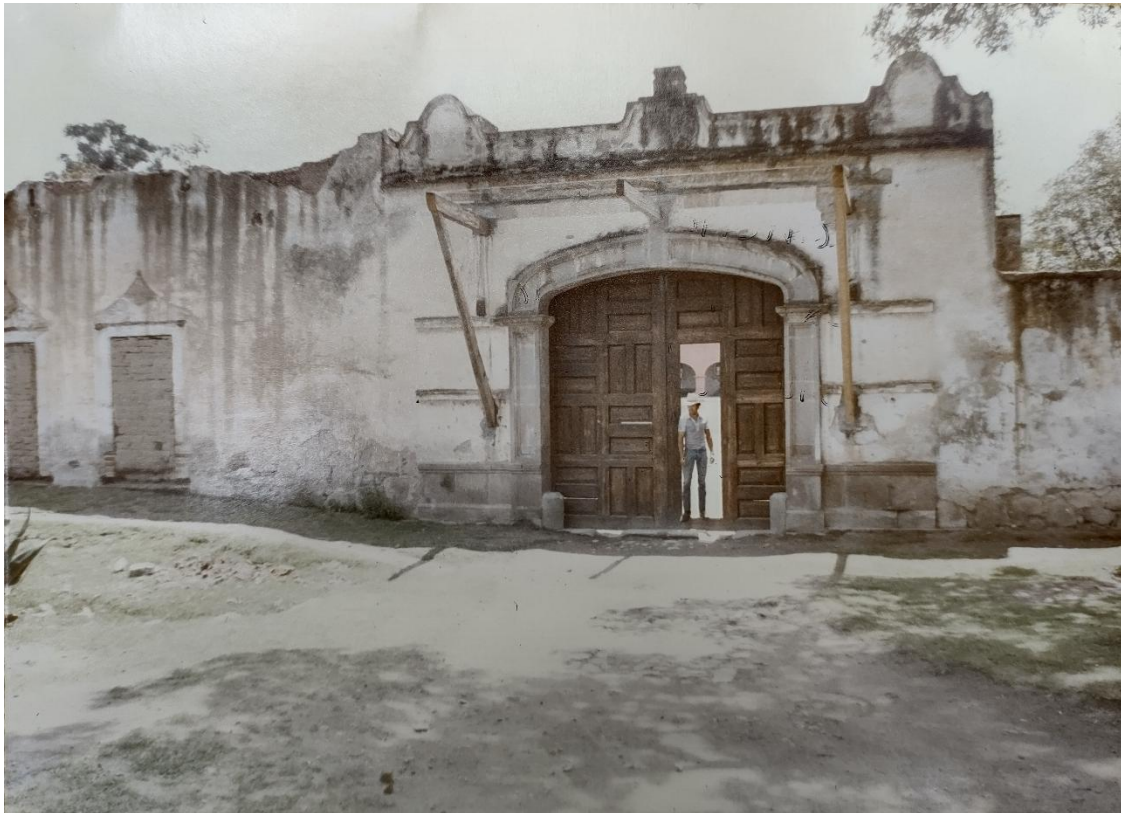
Figura 1. Fachada principal del muro perimetral y acceso al casco de la hacienda de Santa Catarina
