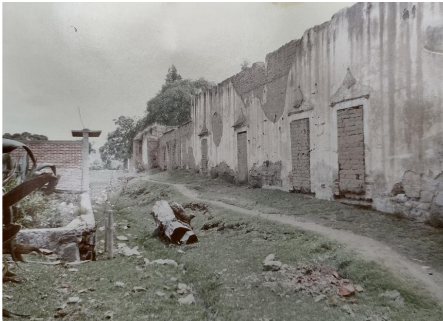
Figura 2. Vista lateral izquierda del muro perimetral del casco de Santa Catarina
