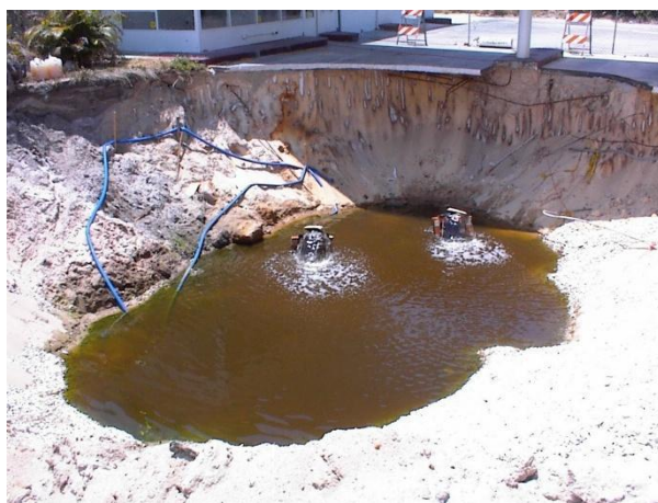
Figura 6 Biorremediación in situ de aguas contaminadas
