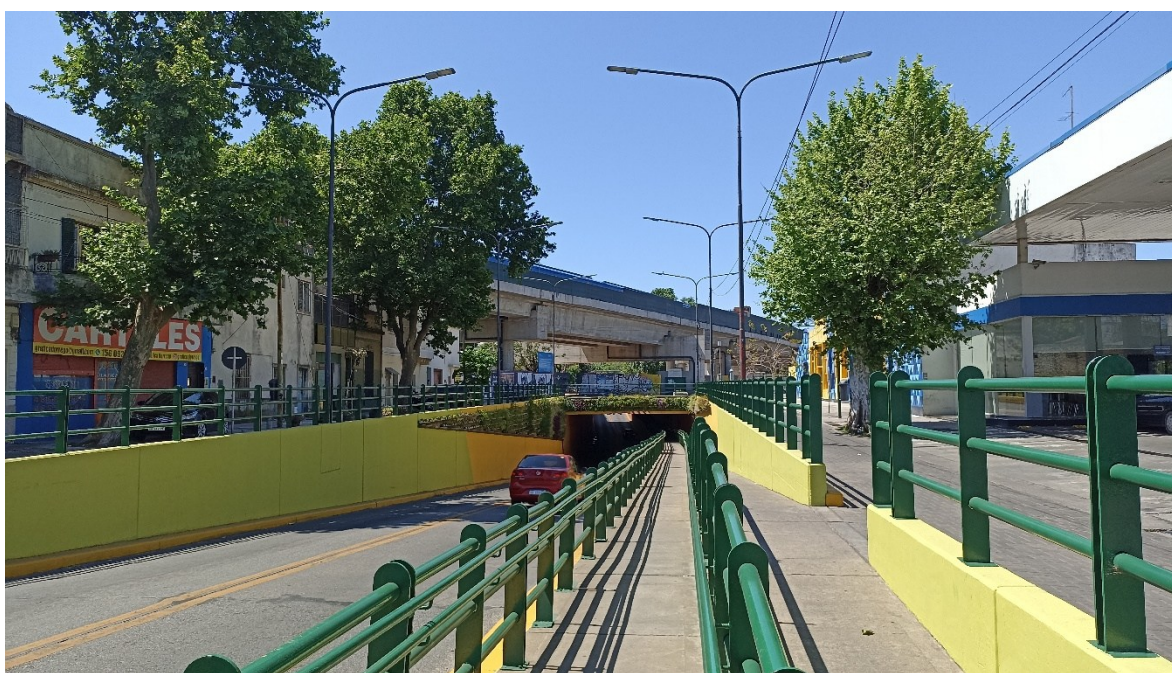
Imagen 6 Viaducto sobre bajo nivel de Avenida Dorrego
