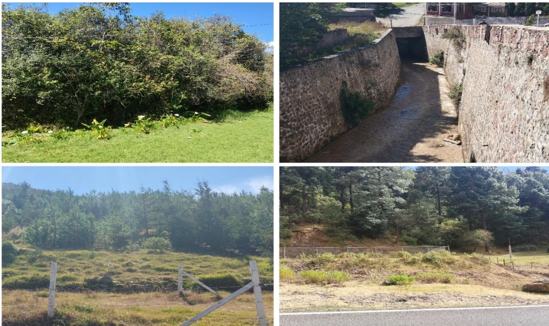
Imagen27. Regueros de hormigón y regueros familiares para contener los deslizamientos y exceso de agua de lluvia
