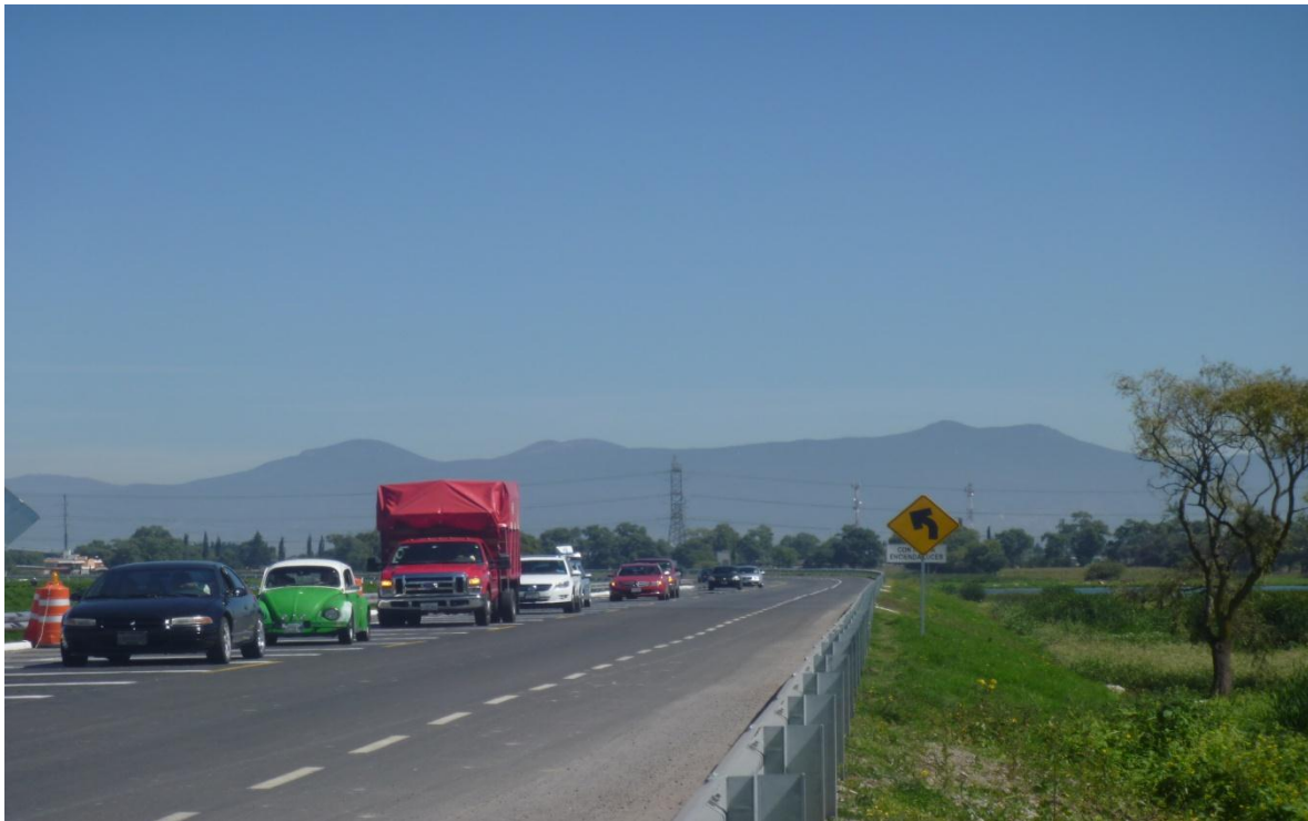
Fotografía No. 3. Autopista Lerma-Tres Marías, a un lado de la laguna de San Pedro Tultepec de Quiroga Fuente: Trabajo de campo. Julio de 2011
