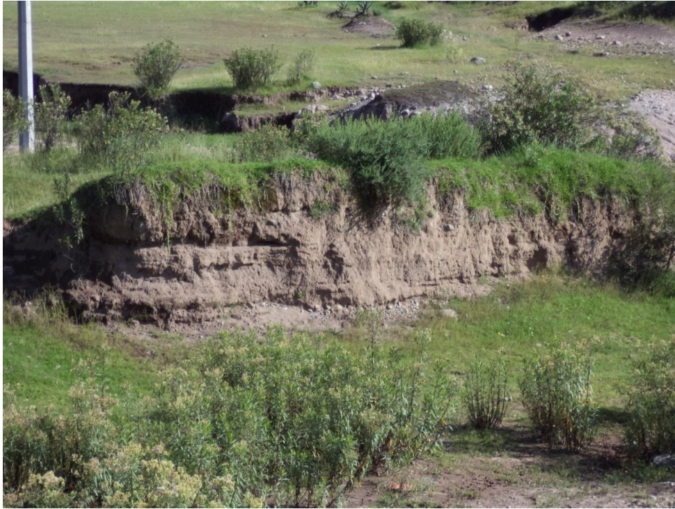
Figura A3 Agrietamientos en el municipio de Jocotitlán
