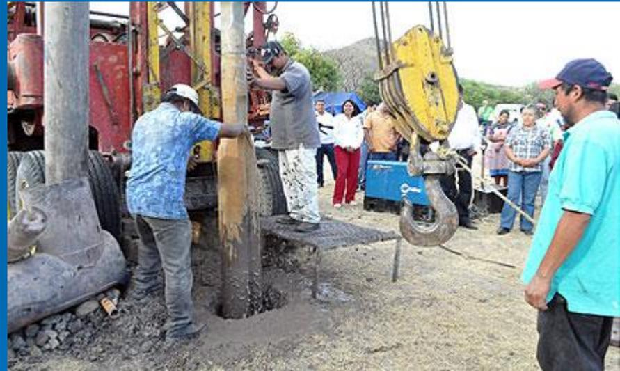
Proceso de perforación de un pozo
