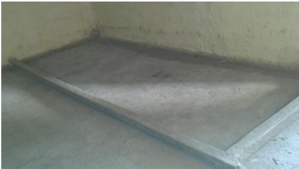
Figura 48. Banqueta elevada dentro de la cámara, que facilita la hidratación de las flores en grandes cantidades por un momento o durante su refrigeración.
