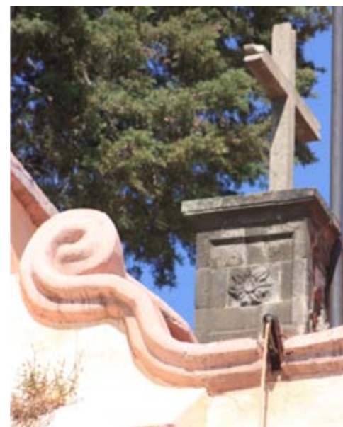
Detalle de remate exterior de la nave con ornamento en forma de volutas (fotografía de Amparo Gómez Castro)
