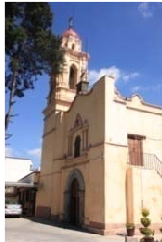
Fotografía 0.4. Fachada y aspecto actual de la Parroquia de San Sebastián Amparo Gómez Castro
