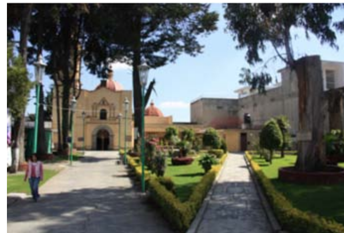
Fotografía 3.8. Atrio de la Parroquia, en muy buen estado de conservación
