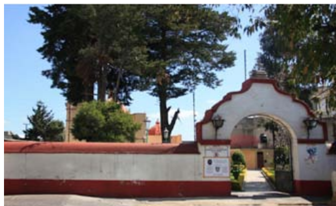
Barda perimetral (fotografía de Amparo Gómez Castro)
