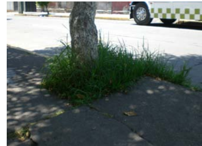
Fotografía 4.3 Banqueta descuidada. Un detalle al que estamos acostumbrados en Toluca. Autor
