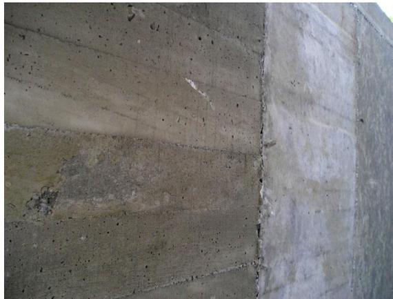
Figura V.7: Acabado de la losa una vez retirada la cimbra.
