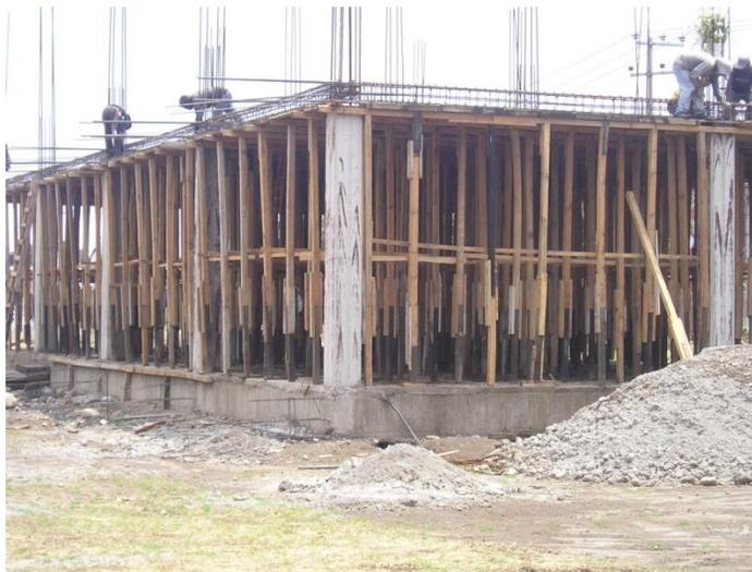
Figura III.9: Construcción de comercio con losa nervada y abundante apuntamiento de madera, Metepec, 2009.
