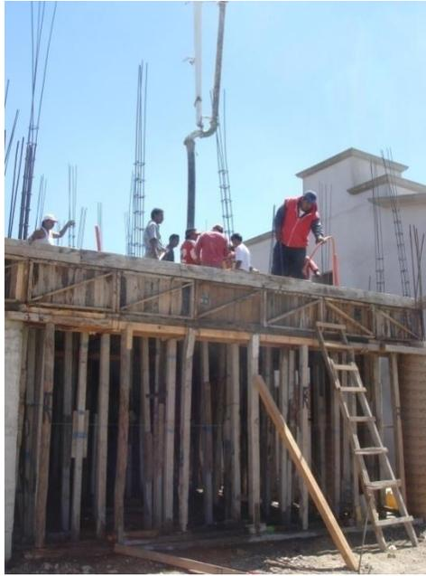
Figura I.2: Proceso de colado de la mezcla de concreto hidráulico sobre cimbra de madera en una casa habitación, Metepec, Estado de México, Arq. Fernando Gil, 2007. Observamos las tarimas colocadas de manera vertical para contener la mezcla a lo largo de una trabe.
