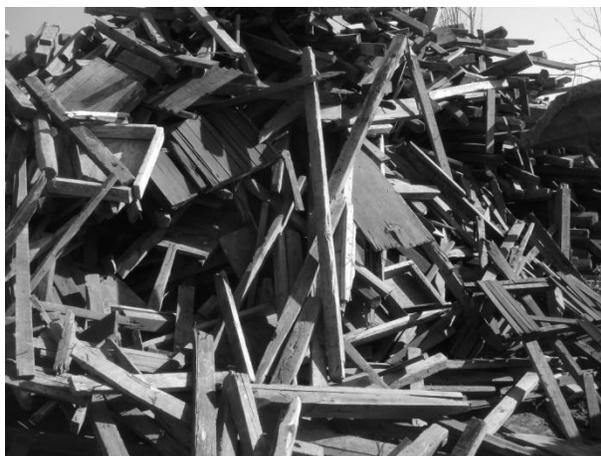
Figura II.1: Desechos de madera en la construcción doméstica convencional. A lo largo del proceso constructivo, la madera sufre dos deterioros, el del contacto directo con el concreto hidráulico y el de sucesivos recortes para satisfacer medidas no modulares. Foto: Andrés Galindo
