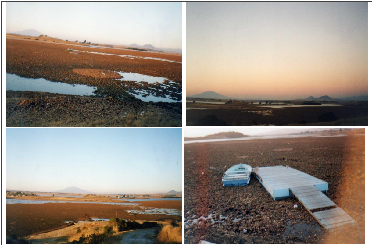
Imagen 28: Presa Ignacio Ramírez, con presencia de lirio acuático, vista desde diferentes ángulos Fuente propia en trabajo de campo 2007.
