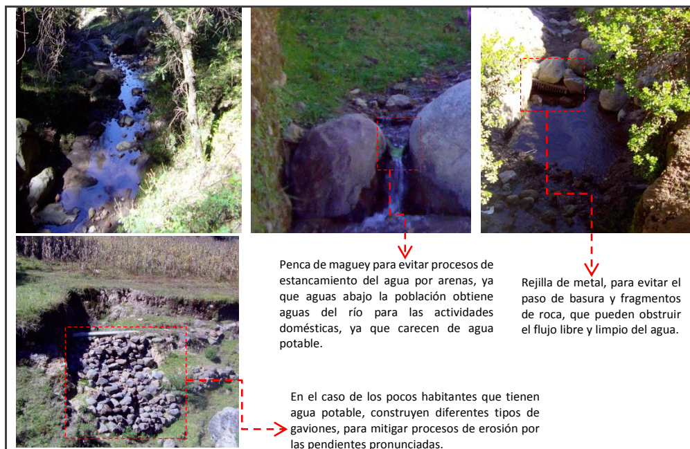
Imagen 29: Medidas estructurales en la cuenca de recepción de San Diego. Fuente propia en trabajo de campo 2012.
