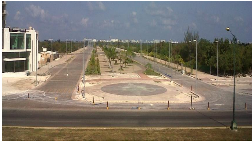
Foto 3.1 Avenida principal del Proyecto Malecón Cancún, 2011
