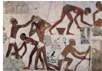
Construcción de adobe en el Egipto antiguo.
