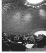
Figura 6. Cúpula sin encofrado.
