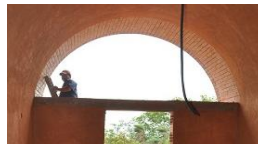
8 Diseño de una casa de adobe en base a bóvedas por Gernot Minke
