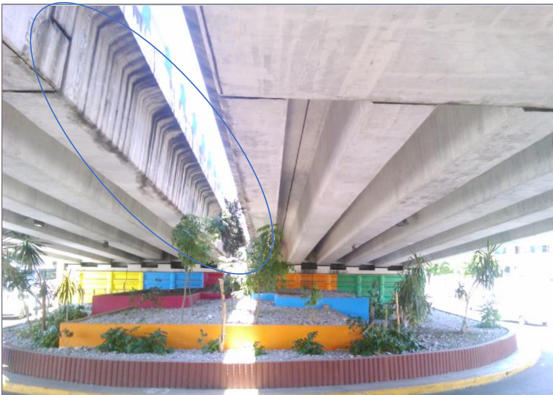
Figura 26. Trabe desfavorable, claro A del cuerpo sureste.
