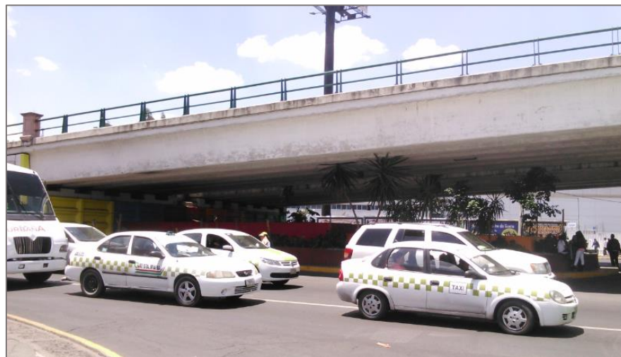
Figura 21. Vista lateral del claro A, cuerpo sureste del puente.
