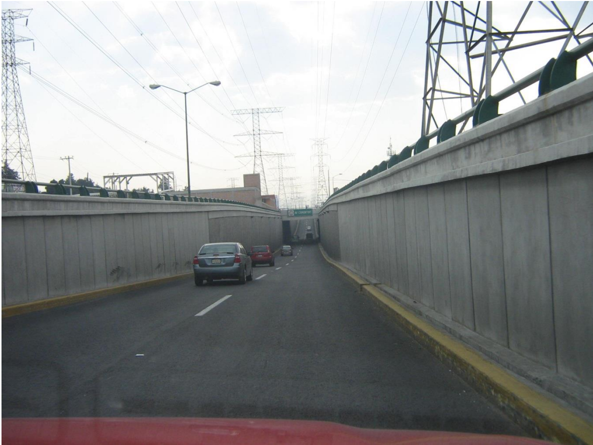
Figura 3.2 Puente Inferior Vehicular construido vista de entrada.
